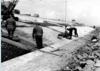
Klem met betonblokken
