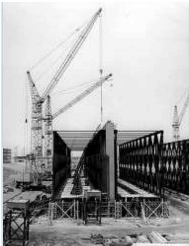
Bouw caisson Bommenede
